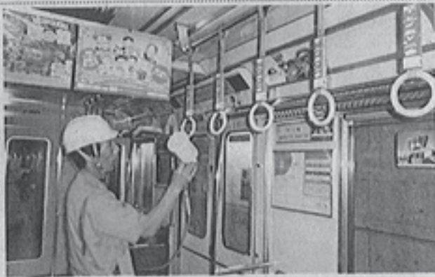
触媒を散布して進められる地下鉄車両の消臭・抗菌化 (大阪市交通局提供)
